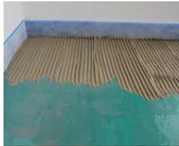
den kleber nach herstellerangaben anrühren und mit einem 6 x 6 mm zahnspachtel vollflächig auftragen. nach möglichkeit in der von der tür eines raums am weitesten entfernten linken ecke mit dem auftragen des klebers beginnen und nach rechts fortführen.
