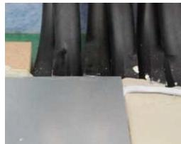
die wärmeleitabdeckbleche dürfen nicht auf den winkelrohrspangen liegen, sondern müssen davor enden.
