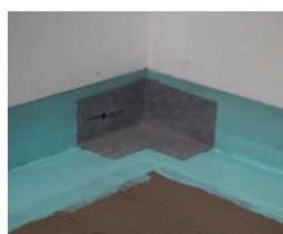
die vorgefertigten eckbänder „indortec seal-db dichtband innenecke“ der fa. gutjahr auf der flüssigbodenabdichtung fixieren und ankleben.
