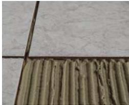
im anschluss kann unmittelbar mit der verlegung des oberbodenbelags entsprechend den einschlägigen vorschriften zu diesem gewerk begonnen werden.
