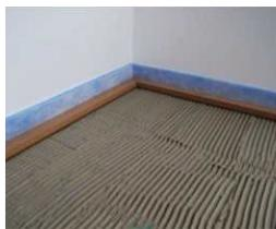
die rahmenhölzer mit der weicheren seite nach unten entlang aller durch randdämmstreifen/dehnstreifen geschützten bauteile verlegen und fest in das kleberbett eindrücken. durch die rahmenhölzer können die angegebenen punkt- und flächenlasten mit dem entsprechenden oberbodenbelag bis in die ecken eines raums hinein genutzt werden.
