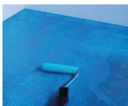
den lastabtragenden boden mit der zum untergrund empfohlenen grundierung als haftbrücke mit einem quast oder einer rolle vorbehandeln. die trocknungszeit der grundierung vor dem nächsten montageschritt beträgt ca. 1-2 stunden. bitte die anwendungs- und verarbeitungsrichtlinien des herstellers beachten.
