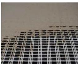
nach der verlegung der entkopplungsmatte EM 4 diese mit sopra vario flex HF 420 kleber vollflächig und lückenlos aus- bzw. abspachteln.
