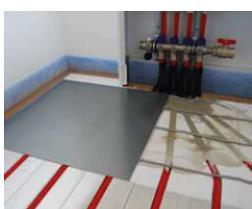
die wärmeleitabdeckbleche fest auf der systemplatte aufdrücken. zwischen den einzelnen blechen müssen immer mindestens 3 mm abstand eingehalten werden, damit sich diese bei erwärmung ungehindert ausdehnen können. zu dicht aneinander liegende bleche können zu ausdehnungsgeräuschen führen.
