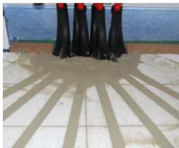
die hohlräume vor dem verteiler mit dem bereits für die befestigung der systemplatten verwendeten kleber plattensbündig ausspachteln. die spachtelarbeiten auf der ganzen anschlussplatte ausführen, um diesen bereich zu stabilisieren.
