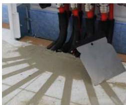
wegen des natürlichen schrumpfungsprozesses der spachtelmasse bei der abtrocknung kann ein nachspachteln notwendig sein, damit keine hohlräume unter der abdeckplatte entstehen. hierzu noch einmal mit einer glättekelle kleber auf den abspachtelten flächen auftragen.
