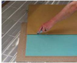
zum kürzen der TB UB 10 platten ein stabiles cuttermesser und eine geeignete anlegeschiene (oder eine platte des TB UB 10) verwenden. die zu kürzende platte mit dem cuttermesser mehrfach einschneiden. die auf der plattenoberseite aufgetragenen markierungen zeigen jeweils die hälfte der platte in der breite, bzw. ein viertel und die hälfte in der länge der platten an.
