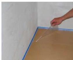
die schutzfolie von den als erstes verlegten 1 1/2 reihen der unterplatten entfernen. im weiteren verlauf der verlegung der oberplatten immer nur die schutzfolie von der direkt für die verlegung der nächsten oberplatte benötigten unterplatte entfernen.
