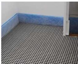
bei der verlegung der entkopplungsmatte EM 4 sind auch kleinste ecken - wie z. b. neben dem verteilerschrank - auszulegen. werden diese kleinsten ecken nicht ausgefüllt, entstehen unterschiedliche bodenbeschaffenheiten innerhalb der heizfläche, die zu schäden in der verbundkonstruktion führen können.
