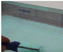
ränder und bodenfläche mit flüssiger dichtmasse komplett gemäß herstellerangaben abdichten.
