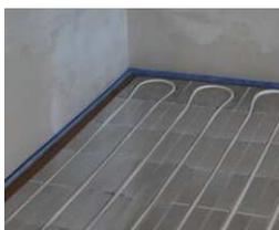
nach abschluss aller bisher beschriebenen arbeiten die flächenheizungssystemplatten von staub und schmutz befreien, um probleme beim aufbringen des trockenbau-unterbodens TB UB 10 zu vermeiden.
