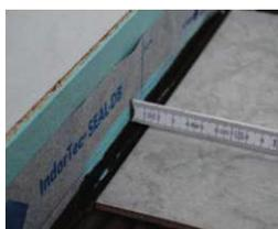
falls der verleger des oberbodenbelags keinen randdämmstreifen/dehnstreifen zur bauteiltrennung mehr setzen möchte, einen abstand von mindestens 1 cm zwischen dem oberbodenbelag und den angrenzenden bauteilen einhalten.
