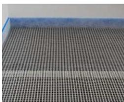
nach der verlegung der entkopplungsmatte EM 4 und der durchführung aller in dieser verlegeanleitung aufgeführten tätigkeiten das hergestellte gewerk an das nachfolgende gewerk des oberbodenbelagverlegers übergeben.
