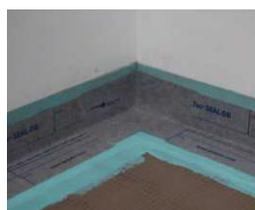
die übergänge vom boden zur wand mit gutjahr „indortec seal-db dichtband“ abdichten.
