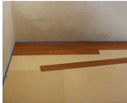
wir empfehlen, den oberbodenbelag innerhalb von 48 stunden nach der verlegung des trockenbau-unterbodens TB UB 10 zu verlegen, um mögliche einflüsse durch luftfeuchtigkeit auszuschließen.
