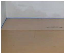
die verlegung immer mit einer ganzen oberplatte in der von der tür eines raums am weitesten entfernten linken ecke beginnen. die platte muss beidseitig unmittelbar am randdämmstreifen anliegen. die oberplatte anwalzen oder andrücken.
