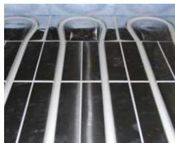
nach abschluss aller bisher beschriebenen arbeits schritte die flächenheizungssystemplatten von staub und schmutz befreien, um probleme beim aufbringen der entkopplungsmatte EM 4 zu vermeiden.
