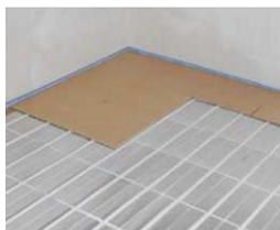
die erste platte der zweiten reihe auf die hälfte der länge kürzen und diese von links beginnend lückenlos an der ersten reihe anlegen. nachfolgend ganze unterplatten nach rechts hin verlegen.
