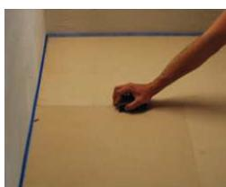
wir empfehlen, die stöße der oberplatten leicht mit der hand anzuschleifen, bevor der gewünschte oberbodenbelag aufgebracht wird.
