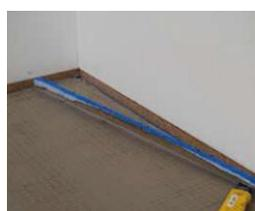
abweichend von der üblichen vorgehensweise, den randdämmstreifen erst nach der verlegung des oberbodenbelags abzuschneiden, den randdämmstreifen/dehnstreifen in feuchträumen unmittelbar vor dem abdichten abschneiden.
