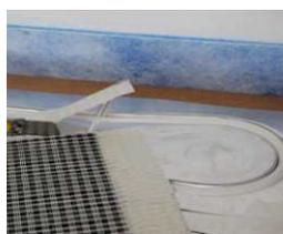
panzergewebe an der langen und der kurzen seite mit dem cuttermesser abtrennen. auch im weiteren verlauf der verlegung die entkopplungsmatte immer vor dem entfernen des silikonpapiers anpassen. mehrmaliges aufnehmen der entkopplungsmatte EM 4 kann zu klebkraftverlusten und beschädigungen führen.
