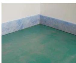
den verstärkten randdämmstreifen/ dehnstreifen entlang der wände, säulen, türen und treppen auf dem ebenen, grundierten, besenreinen, lastabtragenden boden fixieren.
