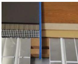
bei einer länge oder breite.: 10 m ist eine dehnfuge im trockenbau-unterboden und dem darauf verlegten oberbodenbelag vorzusehen.
