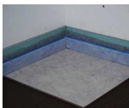
während der verlegung des oberbodenbelags erneut randdämmstreifen/dehnstreifen zur bauteiltrennung setzen.
