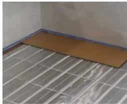
die erste platte der unterplatte auf drei viertel ihrer länge und auf die hälfte ihrer breite kürzen. in der von der tür eines raums am weitesten entfernten linken ecke mit der verlegung beginnen. die platte muss beidseitig unmittelbar am randdämmstreifen anliegen. alle weiteren platten der ersten reihe nur noch in ihrer breite um die hälfte kürzen und lückenlos an die erste platte anlegen.
