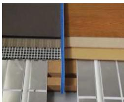
zur herstellung von dehnfugen in türbereichen oder beim wechsel von oberbodenbelägen das zum system gehörende dehnungsfugenprofil tb verwenden. dehnfugen gemäß den angaben der oberbodenbelag-gewerke herstellen. vorhandene dehnfugen bis zur oberkante des neuen oberbodenbelags weiterführen.
