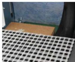
die entkopplungsmatte EM 4 im bereich des verteilers über die winkelrohrspangen hinweg verlegen. sollte die entkopplungsmatte EM 4 in diesem bereich nicht eben durchlaufen, nacharbeiten durchführen.
