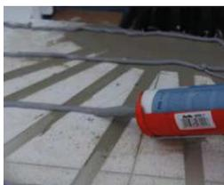
nachdem der kleber in den ausgespachtelten flächen der anschlussplatten ausgetrocknet ist, die wärmeleitabdeckbleche 490 x 490 mm aus 0,4 mm verzinktem stahlblech mit montagekleber aufkleben. hierzu ca. alle 100 mm eine ungefähr 10 mm starke raupe mit kleber auf der verteileranschlussplatte aufbringen.
