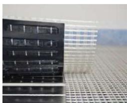
die entkopplungsmatten EM 4 unbedingt lückenlos und dicht aneinander anschließend aufbringen. hohlräume zwischen den entkopplungsmatten EM 4 können zu schäden im oberbodenbelag der verbundkonstruktion führen.
