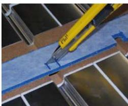
die benötigten rohrdurchführungen anzeichnen und mit dem cuttermesser ausschneiden. die dehnstreifen lassen sich auch noch nach der rohrverlegung anpassen und einbringen.
