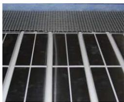
mit der verlegung der ersten entkopplungsmatte EM 4 entgegengesetzt zur verlegerichtung der systemelemente und in der am weitesten entfernten rechten ecke des raums beginnen. das silikonpapier unterhalb der entkopplungsmatte EM 4 entfernen und diese so aufkleben, dass die lange seite der matte über den umlenkbereichen und den rahmenhölzern sowie die kurze seite über den rahmenhölzern liegt und diese mit abdeckt.
