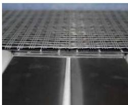
während der verlegung der entkopplungsmatte EM 4 zwischenzeitlich immer wieder den halt der matte kontrollieren.
