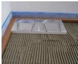
die umlenkplatten mit dem verlegeabstand va 125 oder va 250 mm auf der gesamten auszulegenden und mit fixierkleber versehenen breite des heizkreises oder raums verlegen.
