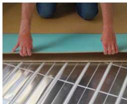
die platte - wie im bild gezeigt - mit einem kräftigen zug nach oben abknicken. das anlegen einer anderen platte an der schnittstelle erleichtert das trennen der platten.
